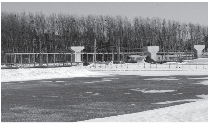
写真8 工事中の新駅
