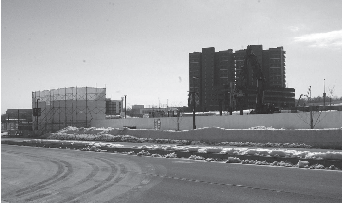
写真7 工事中の施設
