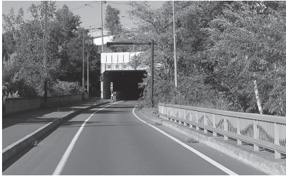
写真5:現在の石山陸橋付近 (旧定山溪鉄道線路跡)
