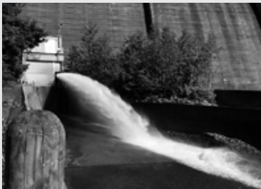
写真⑲ 常用洪水吐からの河川維持放流
