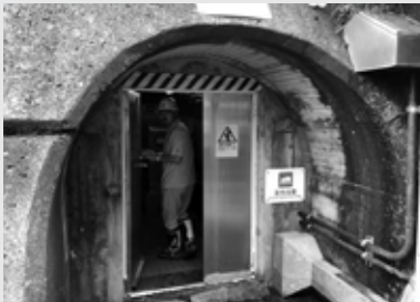
写真⑩ ダム提体内入口
