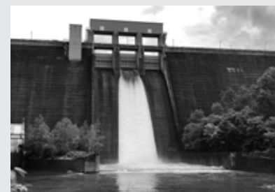
写真⑧ 非常用洪水吐（ゲート）からの放流
