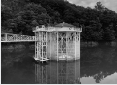
写真⑰ 取水塔
