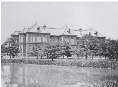
八角塔のない赤れんが庁舎
