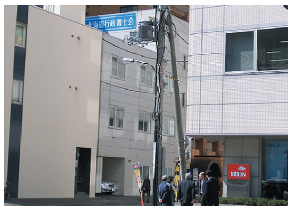
屋上看板 北2条側から
